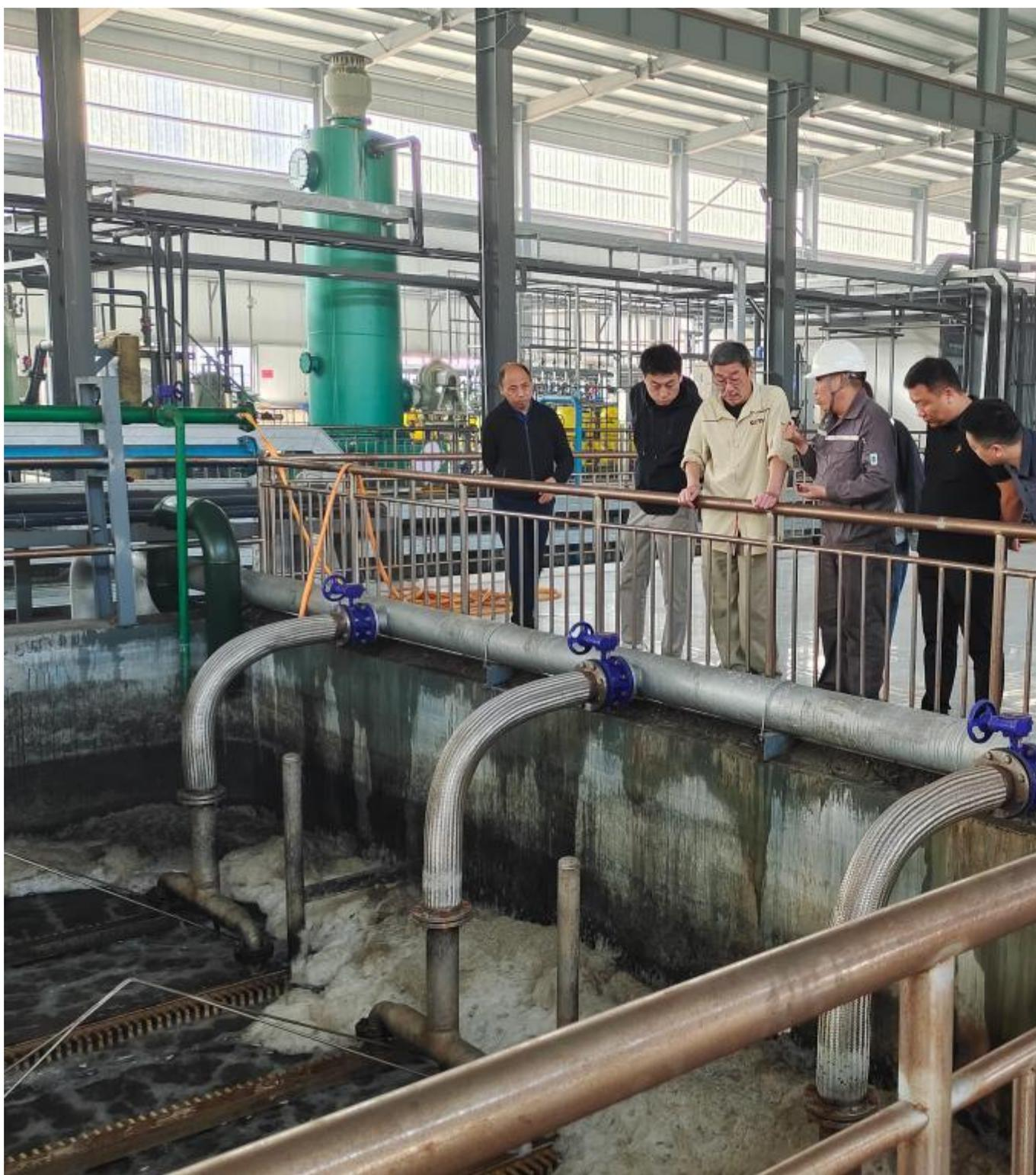
“咱們的再生水到了淨化車間，通過過濾脫鹽以後，好水再回來到焦爐的冷卻體系循環利用，一部分蒸騰掉了，另一部分回來來再通過這個體系過濾脫鹽，再回來來用，這是一個循環的體系，根本實現了零排放。”柴艇龍說。
